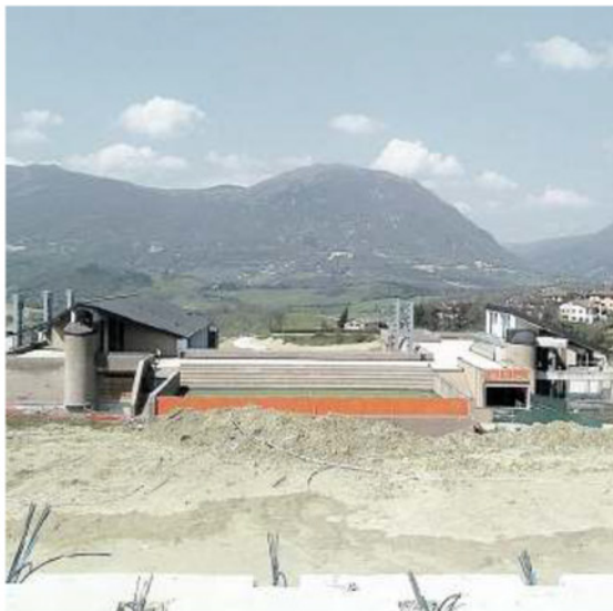
I lavori al polo scolastico
